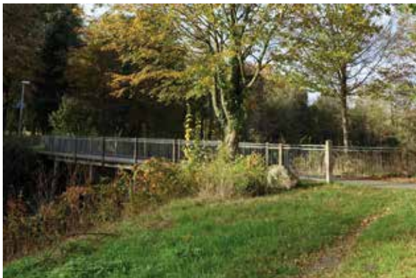
Brücke über den Stausee am Sportplatz Sternbusch
