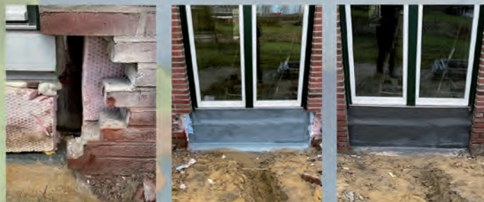
Abdichtung bodentiefer Fenster
